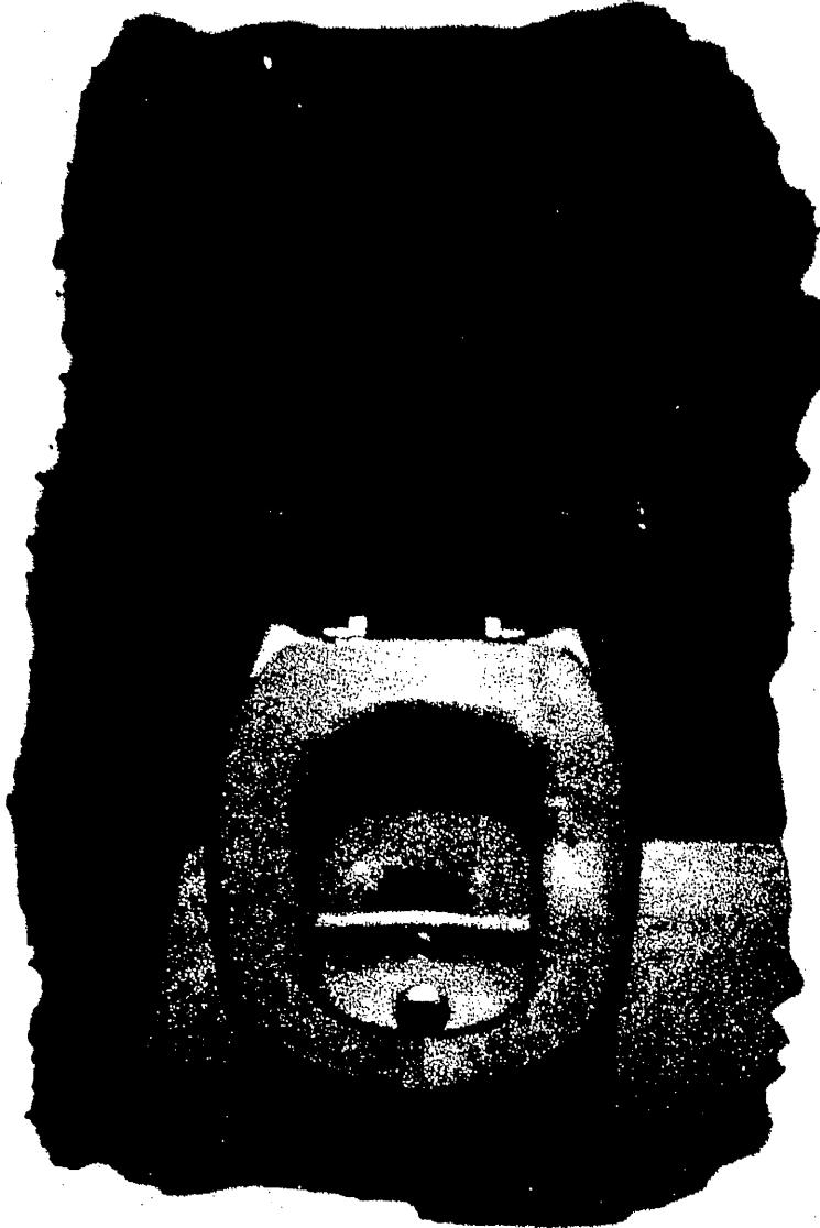
*Det urinseparerende toilet er såre simpelt indrettet, med en kumme delt i to og med to rør fra kummen med forbindelse til henholdsvis urintank og kloaksystem.*
